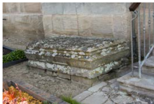
Richtersgruft vor der Renovierung
