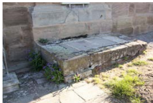
Unterbau der Pfarrersgruft vor der Renovierung
