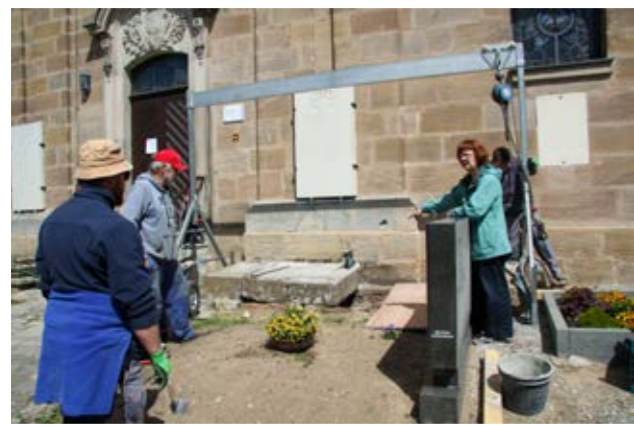
Astrid Scharpff und Georg Lang beraten über den schadhafte Zustand der Pfarrersgruft
