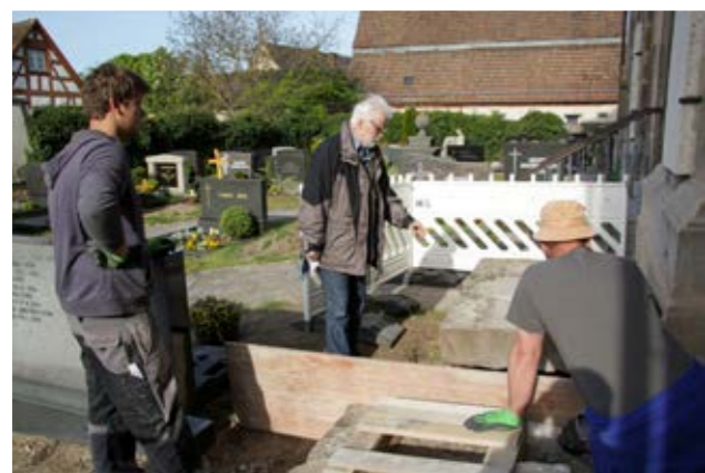
Winfried Weirauch gibt wertvolle Tipps zum Erstellung eines sicheren Unterbaus
